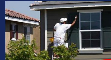
Restauração PINTURA DE FACHADA
