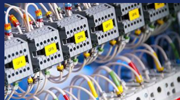
Reestruturações HIDRÁULICAS E ELÉTRICAS
